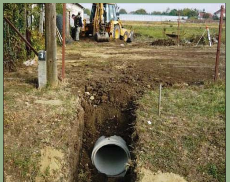
Az óvoda mellett megépült egy vízvezető árok, amely a csapadékvíz és a talajvíz elvezetésére szolgál. Nemcsak a kertekből folyik el így majd a víz, az óvoda falai is szárazabbá válnak. Az árkok kialakítása jó példa az érintett lakosság és az Önkormányzat együttműködésére, a közös érdek megvalósítására.
